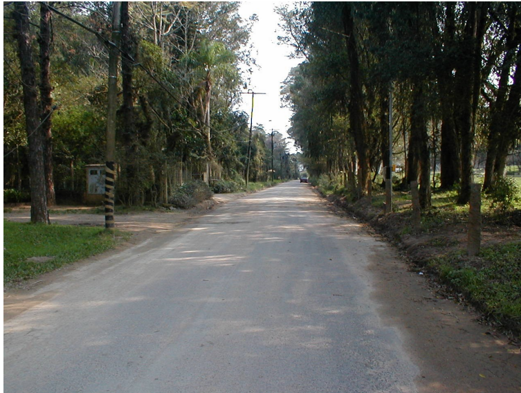
FOTO 1: Início do trecho de projeto (asfalto).
