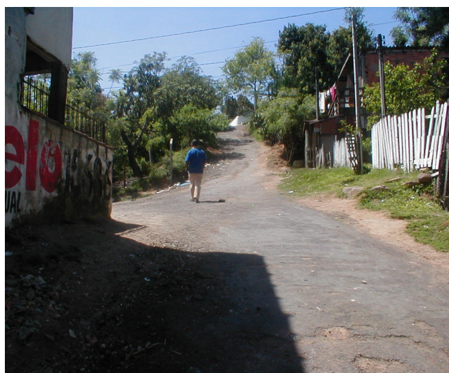
FOTO 6 - Final do trecho de projeto de pavimentação
