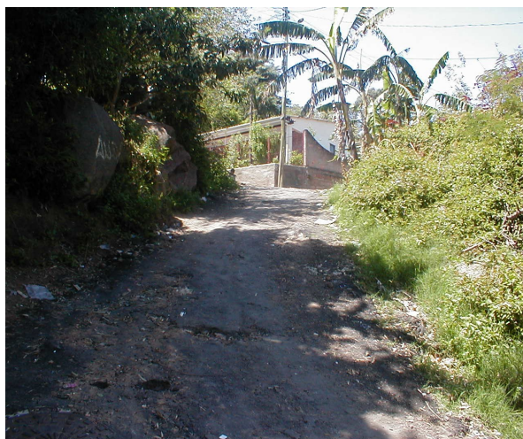
FOTO 3 – Detalhe do estreitamento da Rua.
