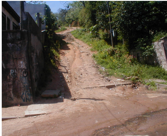
FOTO 1 – Início do trecho de projeto - Rua Santa Teresa com a Rua Santa Maria.
