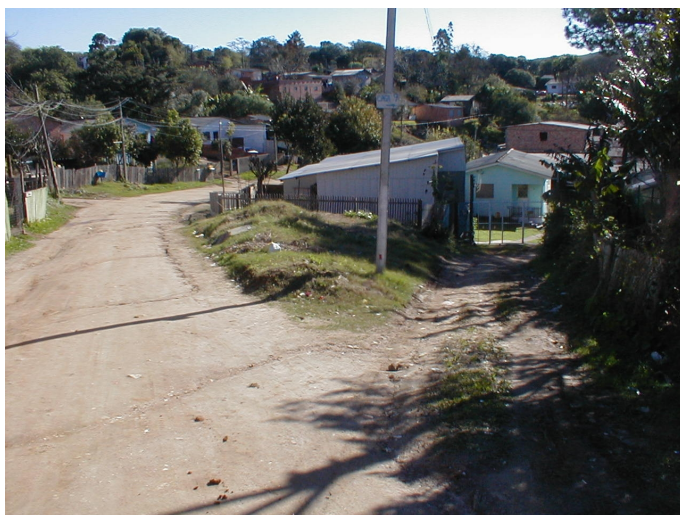
FOTO 2: Detalhe do acesso de veículos est. 2, lado direito
