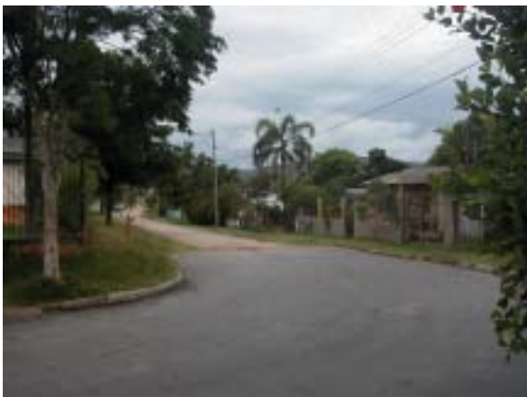
Foto 01: Início do trecho, no final do pavimento existente da rua "C".
