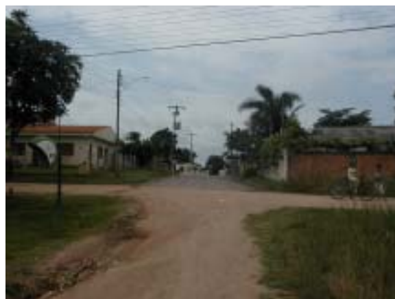
Foto 04: Vista da Travessa "F". Transversalmente vislumbra-se o trecho de projeto com estaqueamento da esquerda para a direita.
