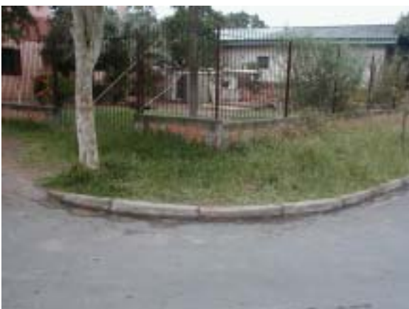
Foto 03: Localização RN 0, em cima do meio-fio, na esquina da Rua "C" com a Rua "B", a aproximadamente 10m do PP (ponto de partida).
