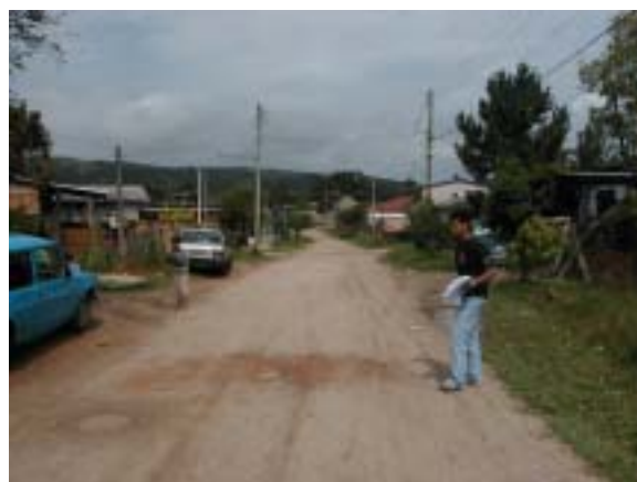
Foto 06: Vista a partir do km 0+100. Próximo ao eixo da rua vê-se furo de sondagem executado.
