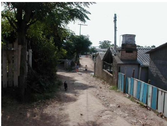
Foto 13: km 0+170 – Vista das condições atuais do subleito da rua, na direção do estaqueamento.
