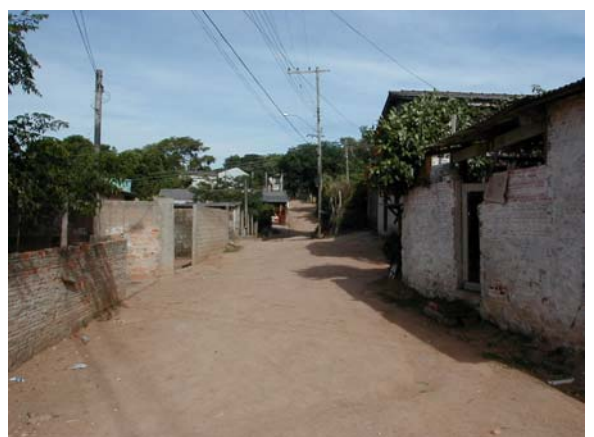
Foto 16: Estreitamento do logradouro existente próximo ao km 0+200.
