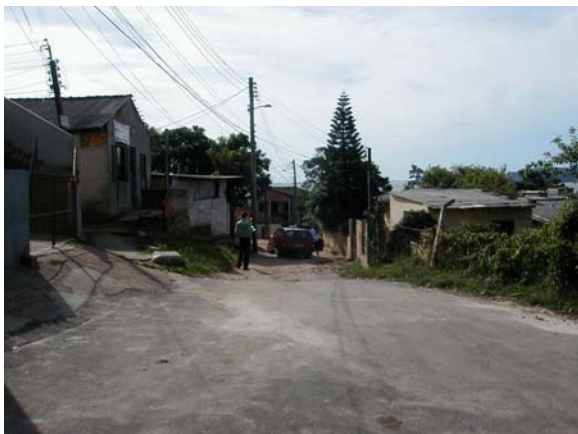
Foto 01: Ponto de partida - km 0+000 - final do pavimento existente.
