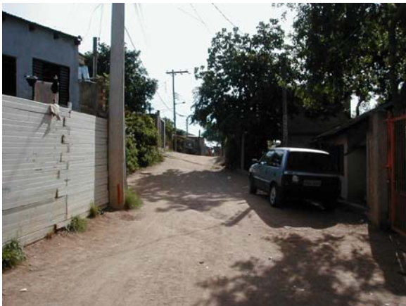
Foto 11: Km 0+120. Poste de concreto, contendo rede elétrica (AT, BT, TRAFO, luminária) e rede telefônica.
