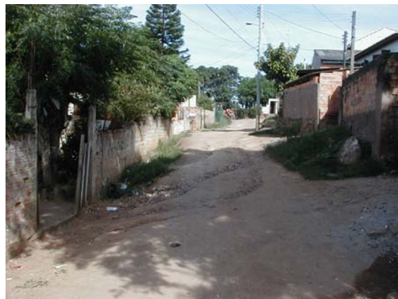
Foto 02: Vista do trecho no sentido contrário ao estacionamento a partir do km 0+020. Segmento com previsão de muro de contenção (Muro 01).
