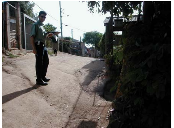
Foto 12: km 0+140 – Detalhe de afloramento rochoso no subleito da rua.
