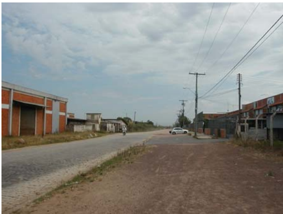
Foto 07: km 0+040, água da chuva empoça junto ao meio-fio existente, vide faixa clara na borda direita.
