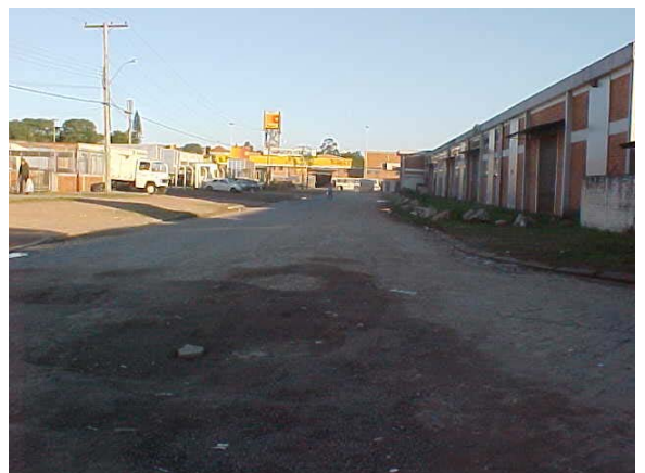
Foto 10: Vista na direção do início do trecho, do km 0+100 ao km 0+000. Ao fundo, Av. Sertório. À direita, prédio (pavilhão) para depósito desativado.
