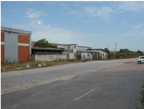
Foto 11: Detalhes de casas/casebres no lado esquerdo km 0+170.
