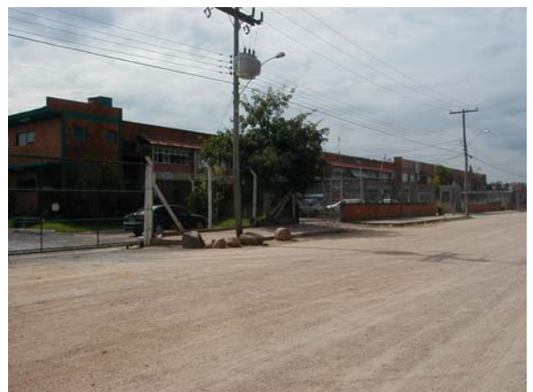
Foto 16: Vista geral do lado direito da rua (km 0+240).
