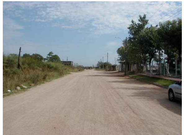
Foto 14: Vista na direção do final do trecho (km 0+200), plataforma revestida com saibro.
