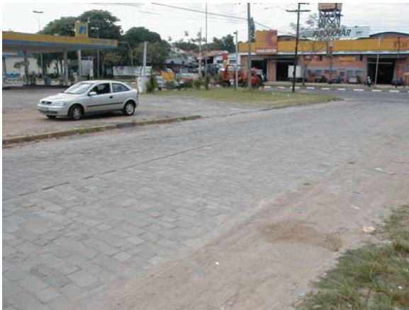
Foto 05: Posto de gasolina existente no lado direito, no início do trecho. Em detalhe, calçamento existente.
