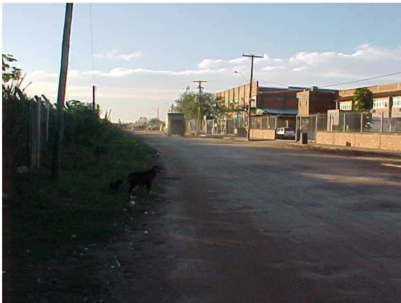
Foto 13: Vista na direção do final do trecho, km 0+160 ao km 0+260. Na foto, detalhes do tráfego do caminhão do lixo.
