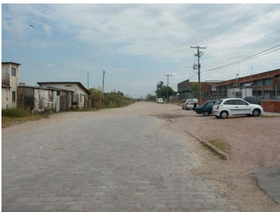
Foto 09: km 0+170. Final do calçamento existente.
