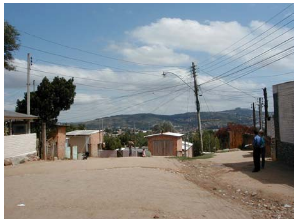
Foto 20: Vista do trecho a partir do km 0+130.
