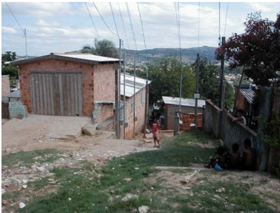
Foto 23: A direita passagem de pedestres, local de implantação de escadaria (km 0+160).
