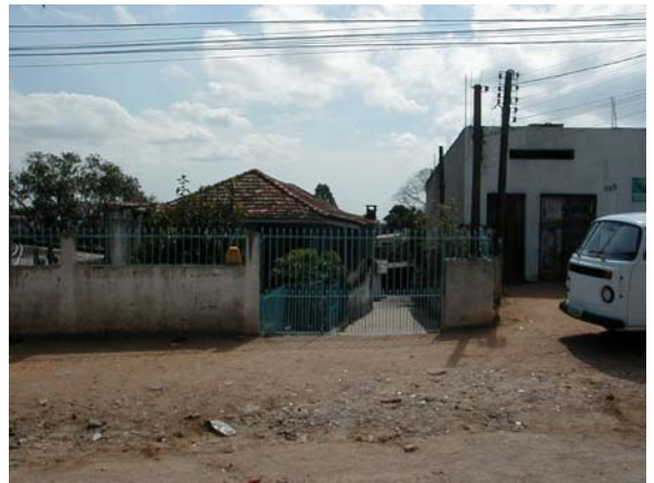
Foto 18: Residência localizada no km 0+120 LD, notar soleira bem abaixo do nível da rua.
