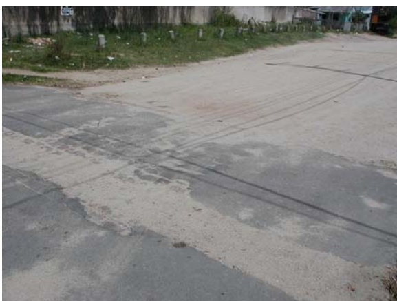
Foto 03: km 0+005 – detalhe do bordo do pavimento existente.
