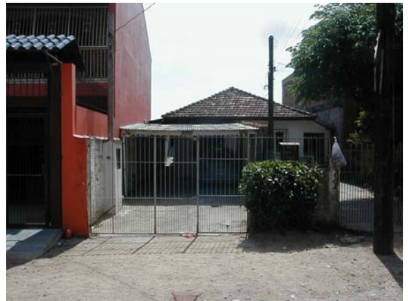
Foto 14: Construções km 0+080 LD.
