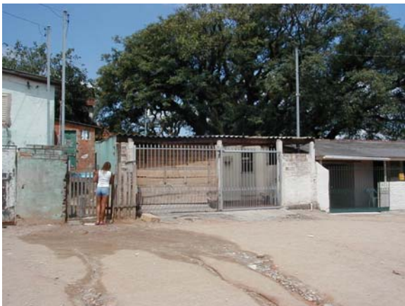
Foto 19: Residências, km 0+130 LE.
