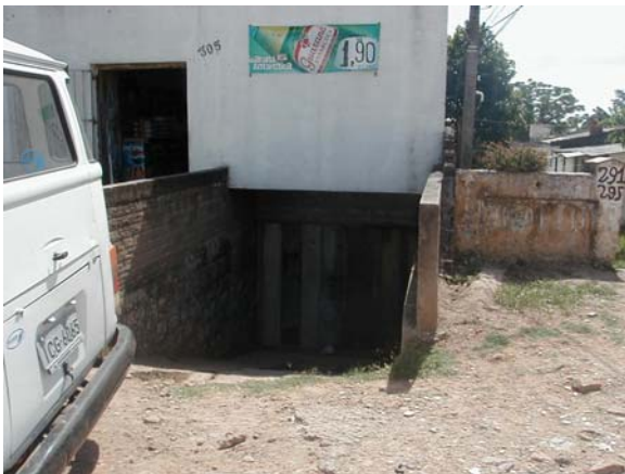
Foto 25: Detalhe da foto 17, acesso a garagem.
