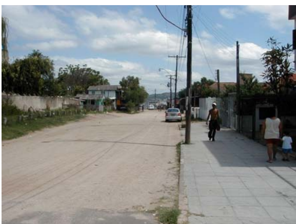
Foto 05: Detalhe da rede elétrica no passeio direito.
