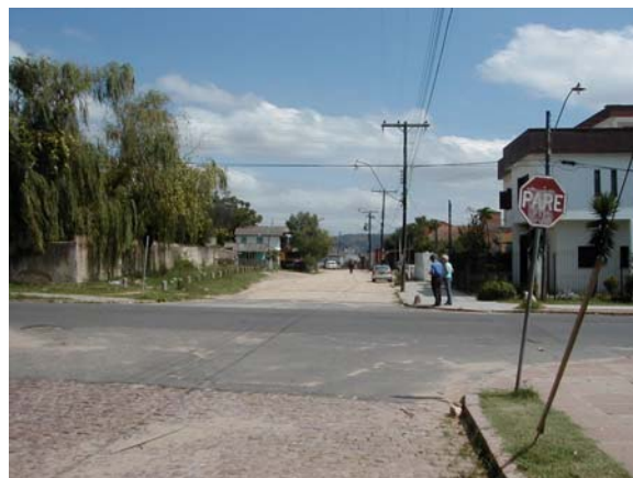
Foto 02: Início do trecho - km 0+000 - no eixo da Rua Bom Jesus (asfalto).
