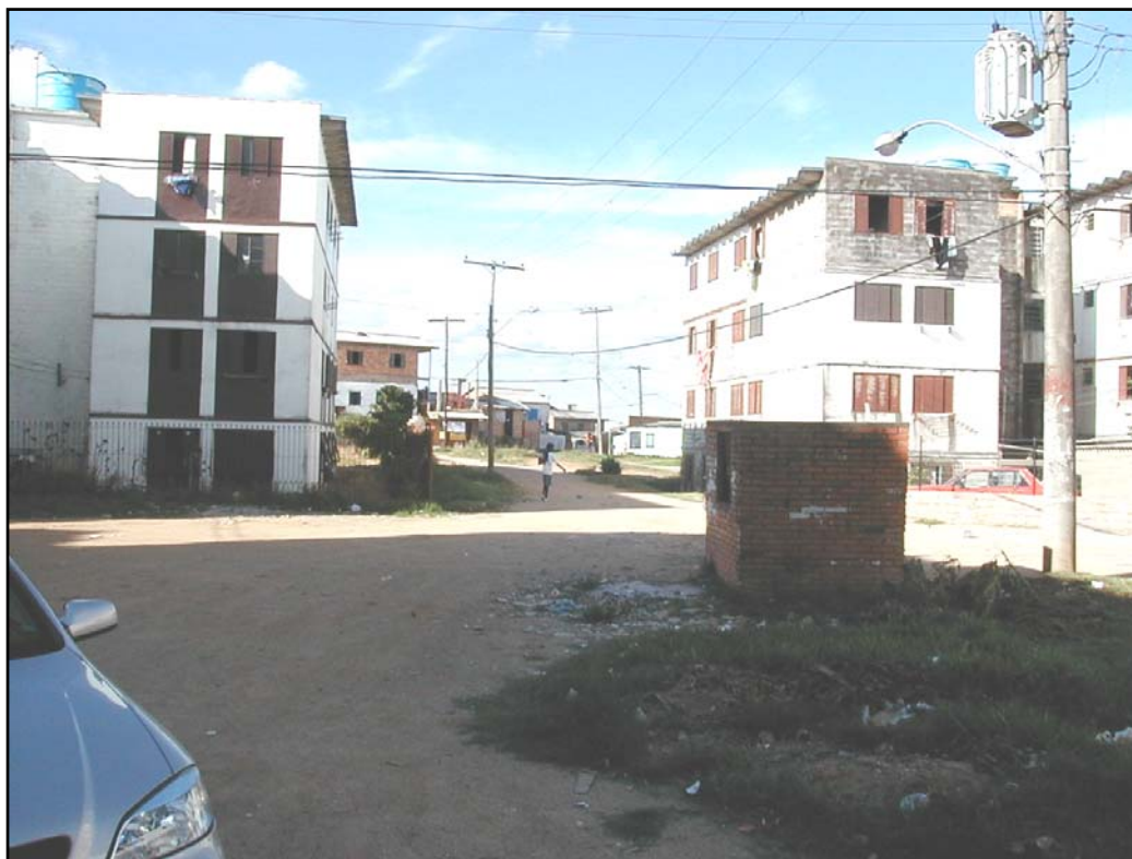
Foto 01: Vista a partir do final do trecho. À direita vislumbra-se lixeira e poste de concreto a serem deslocados.
