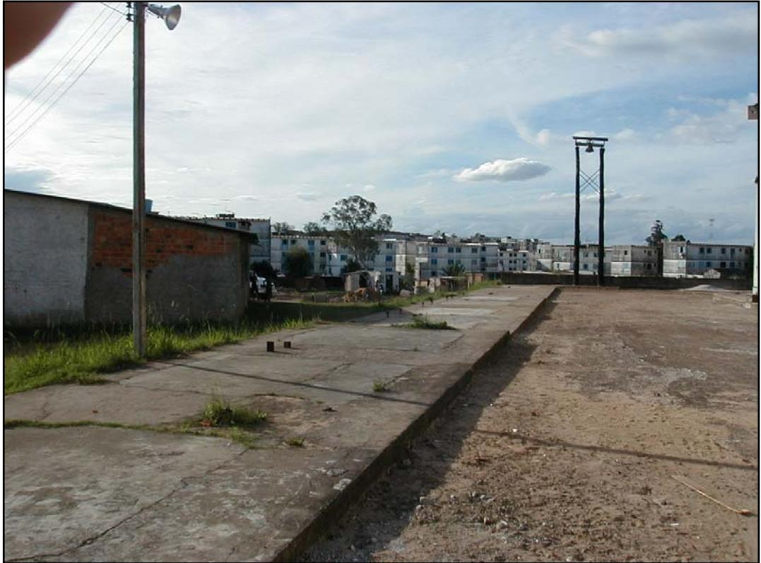
Foto 03: Placa de concreto a ser removida entre as estacas 0+204 e 0+236.
