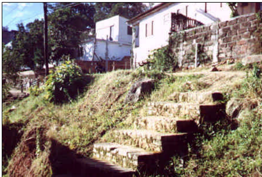
Foto 11: Escada km 0+180 no lado direito da rua Santa Maria.
