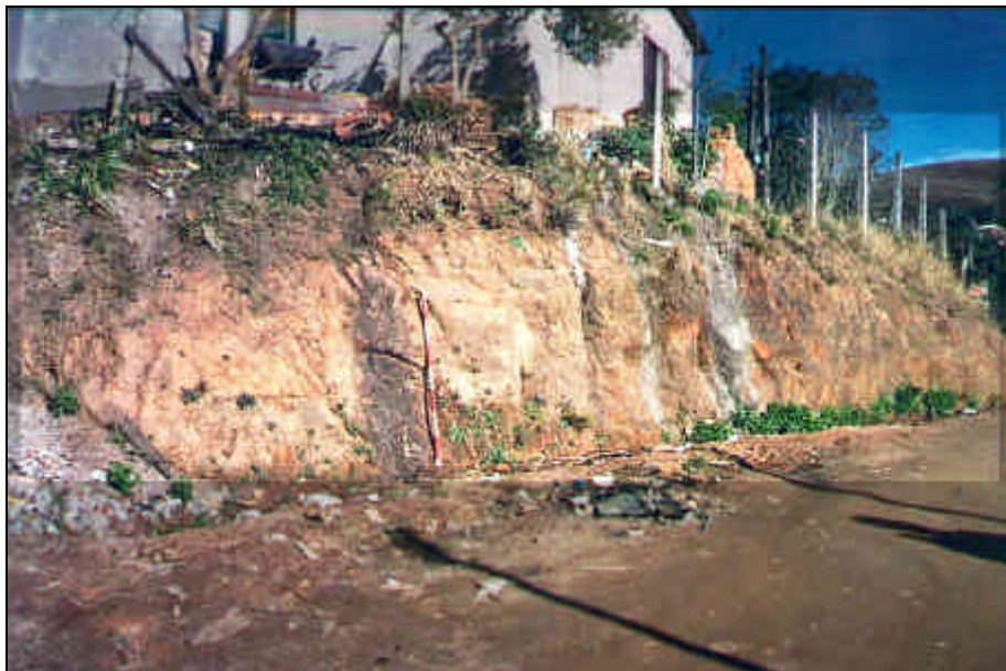
Foto 22: Estaca 0+250 . Solo saprolítico no topo e saprólito de rocha na base. Afloramento existente no cruzamento entre as ruas Santa Maria e Santa Tereza.
