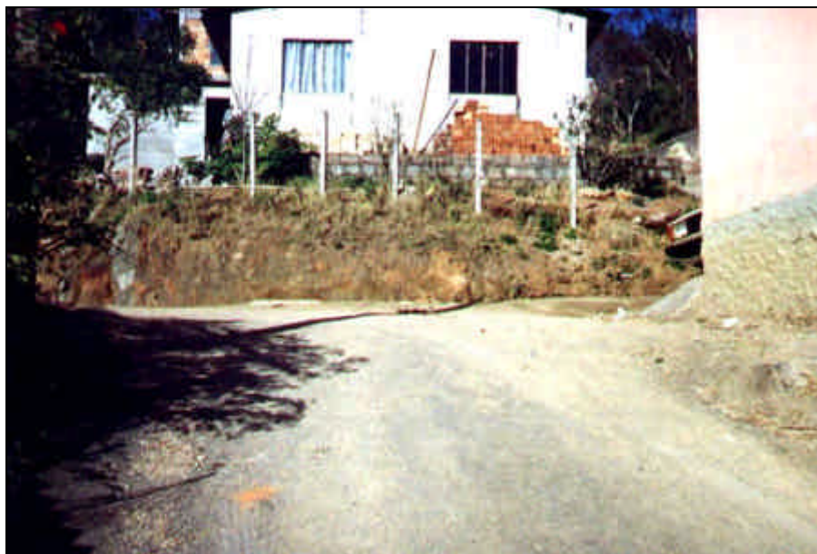
Foto 15: Vista da Rua Santa Tereza em direção à Rua Santa Maria entre os km 0+260 e km 0+270 da rua Santa Maria.
