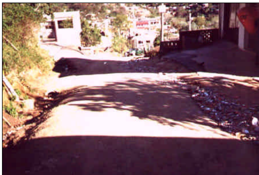
Foto 4: Vista parcial da rua Santa Maria entre km 0+060-km 0+100. A direita está o Bar do prédio nº 1825, no km 0+080, cuja calçada será rebaixada. A esquerda, no km 0+100, vê-se o cruzamento Santa Maria-Bandeira.
