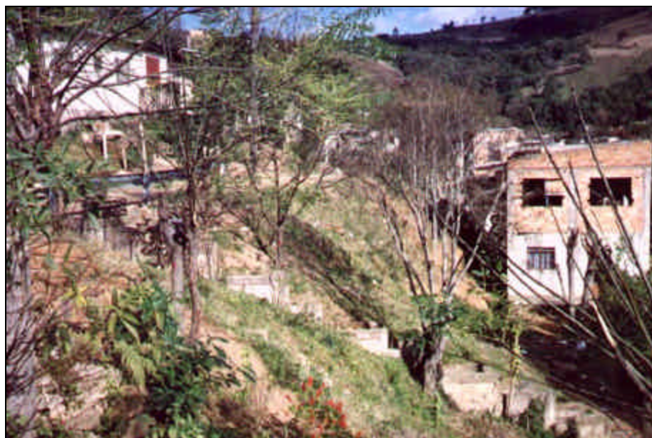
Foto 8: Vista da descida d'água em degraus (km0+160), a direita da rua Santa Maria.
