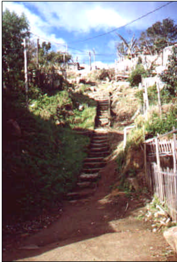
Foto 10: Escada km 0+170 no lado esquerdo da rua Santa Maria.
