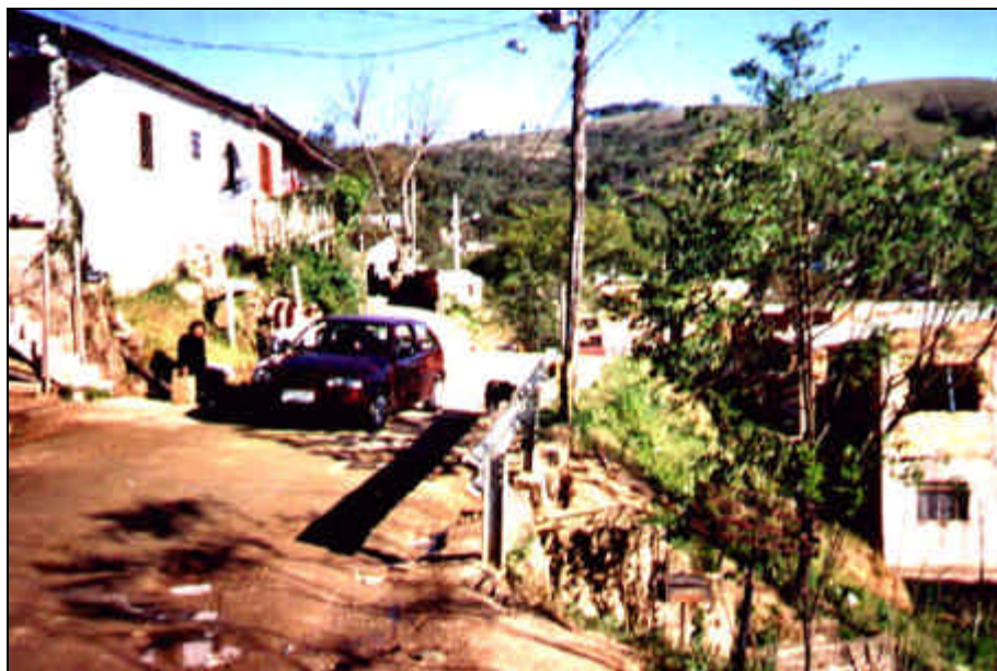
Foto 7: Vista parcial (km 0+150-km 0+180) da rua Santa Maria. A direita da defesa está a descida d'água.
