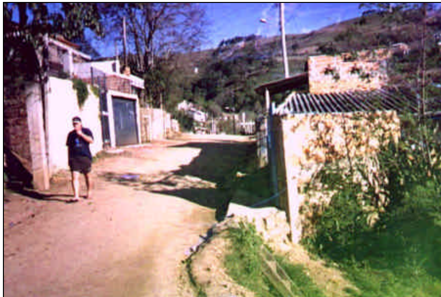
Foto 17: Vista parcial da rua Santa Maria km 0+290-km 0+310, onde observa-se, a esquerda, uma garagem que deverá ser demolida para a implantação das obras de contenção da rua Santa Maria.
