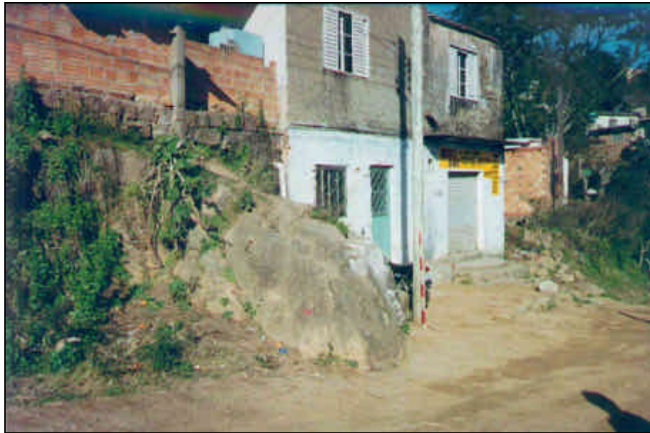
Foto 21: Estacas 0+180 a 0+230 . Solo saprolítico com ocorrência de matacões, sendo alguns de grande porte, como mostra a fotografia ao lado. Matacão na estaca 0+226.
