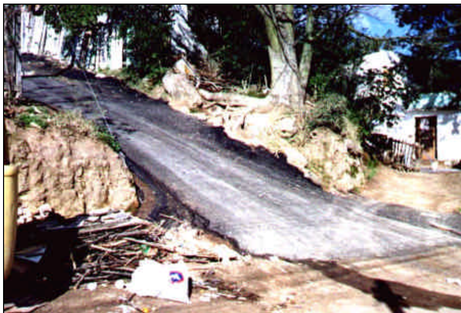
Foto 3: Vista da Rua Saul Constantino, do lado esquerdo, na estaca km 0+060, no cruzamento com a rua Santa Maria. O greide da rua Saul Constantino deverá ser rebaixado.
