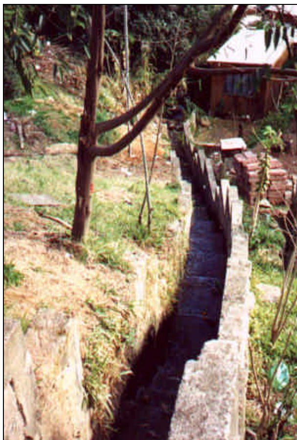
Foto 9: Vista de cima da descida d'água em degraus (km 0+160), com as paredes em alvenaria de pedra.
