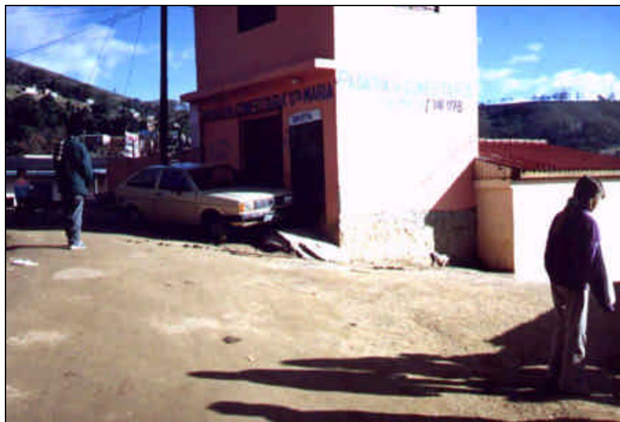
Foto 14: Vista parcial km 0+250-km 0+270 da rua Santa Maria. A direita está a rua Santa Tereza.
