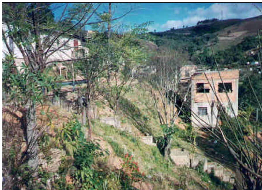
Foto 19: Estacas 0+130 a 0+200 . Panorâmica do trecho de encosta (talvegue) onde o curso d'água é canalizado por uma descida d'água em degraus.
