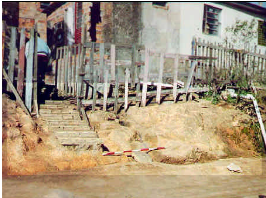
Foto 18: Estaca 0+040 . Saprólito de rocha. Material rígido classificado como rocha alterada.
