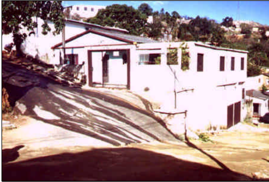
Foto 5: Vista parcial da rua Santa Maria (km 0+100-km0+130) e da Rua Bandeira no lado esquerdo. O cruzamento das duas ruas está localizada no km 0+100.
