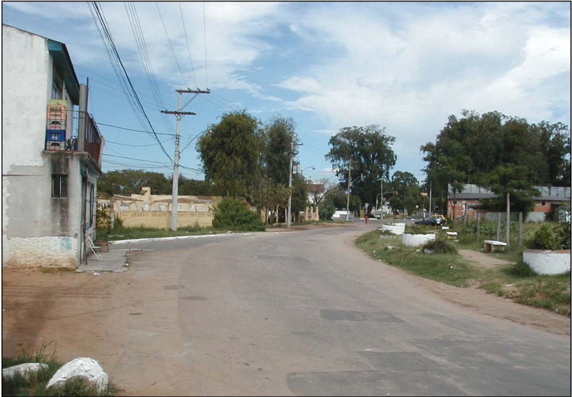
Foto 01 – Vista da rua, na direção do cruzamento com a Av. Icarai, onde é o início do trecho. Destaca-se a existência de tratamento contra pó (capa delgada de CBUQ) em toda a extensão.
