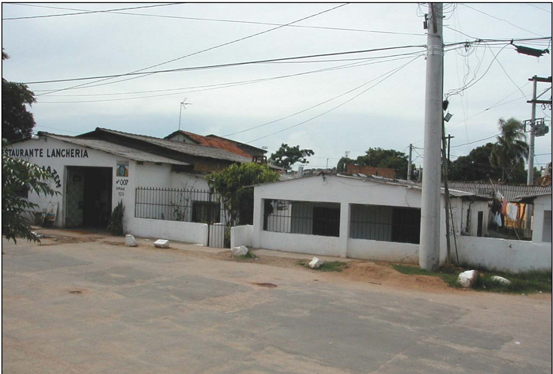
Foto 02: Detalhe de casas existentes no lado esquerdo (estaca km 0+100) cujas soleiras estão abaixo do nível atual da rua (casa n.º 9 e n.º 11).
