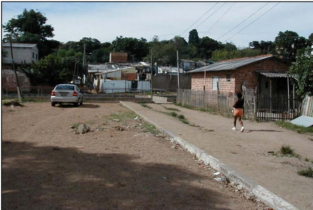
Foto 4: Vista do lado direito da Rua Jataí, antes do cruzamento com a futura Av. Divisa, verificando-se a existência de meio-fios que deverão ser removidos durante a pavimentação. Os meio-fios poderão ser reaproveitados.
