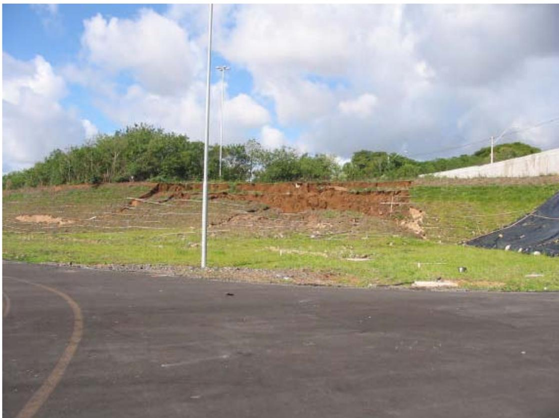
*Figura 2 – Talude rompido (Seção 0+555).*
