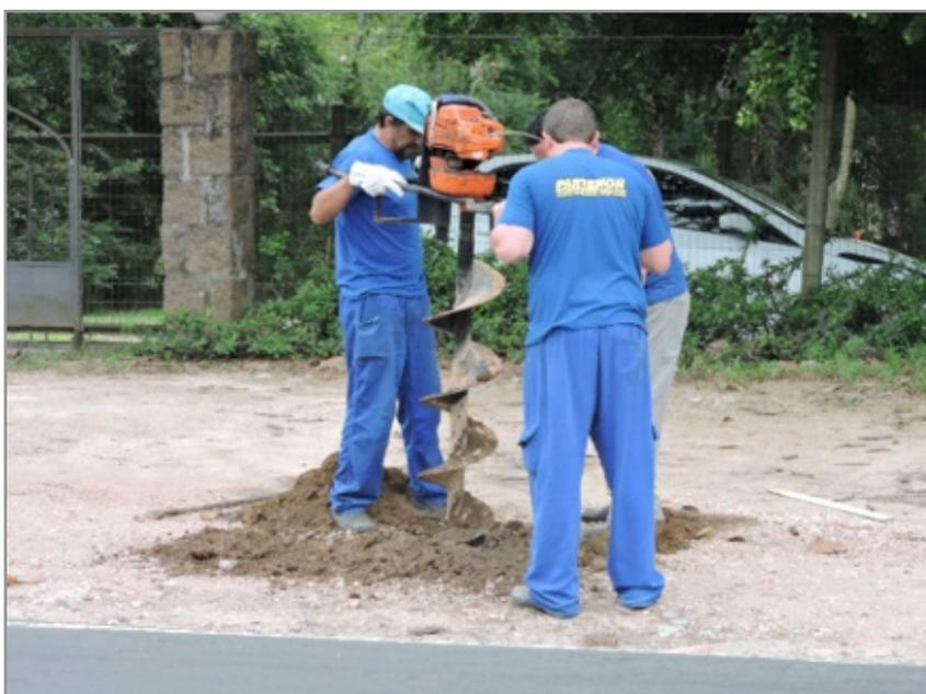
**Figura 25.** Broca motorizada utilizada para fazer os buracos para instalação dos postes.
