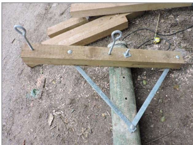
**Figura 22.** Suporte de madeira para fixar a ponte de corda no poste, a ponte de corda é amarrada nas hastes âncoras que funcionam também para esticar a ponte.
