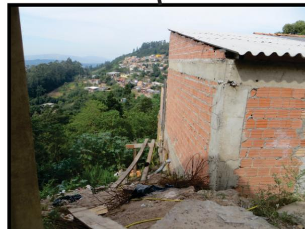
**Descrição:** Ocupação em encosta vale muito íngreme composta por solos coluvionares provenientes de alteração de rocha granítica. Casas construídas rente a crista do vale sob aterros. Casa de alvenaria e mista com médio a alto grau de vulnerabilidade.
