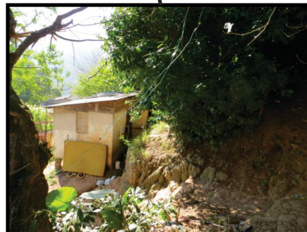
**Descrição:** Ocupação em encosta de morro com alta declividade composta por solos residuais e coluvionares arenoargilosos provenientes da alteração de rochas graníticas. Casa pequenas de alvenaria e mista com vulnerabilidade alta. Precariedade na condução das águas das chuvas e servidas saturando o solo de forma generalizada. Interferência antrópica na meia encosta com supressão vegetal e execução de corte/aterro.
